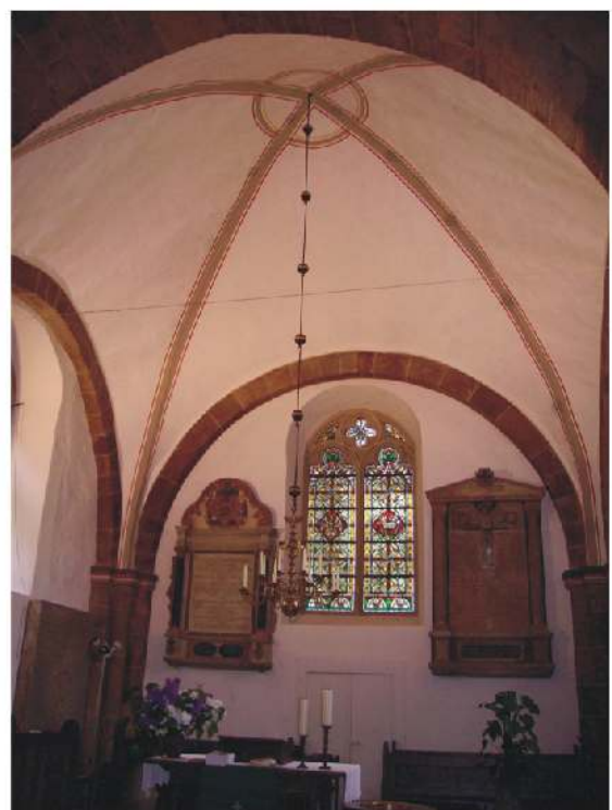
Das Gewölbe der Apsis
