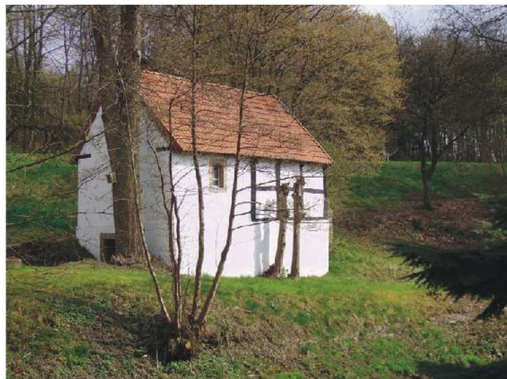
Backhaus Mühle Bohle
