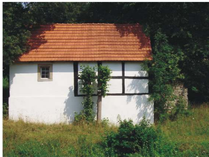
Backhaus Mühle Bohle
