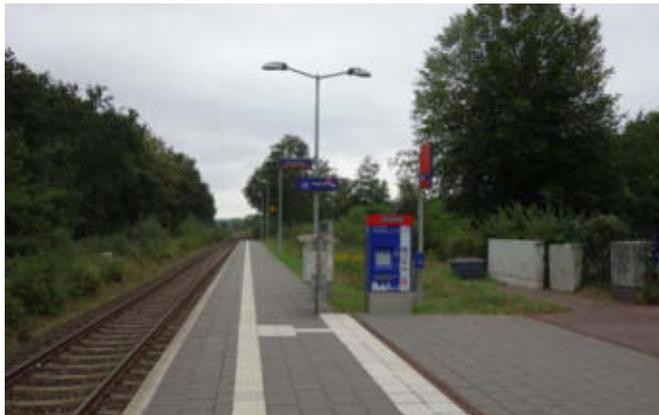
Abb.38: Taktile Elemente am Bahngleis
