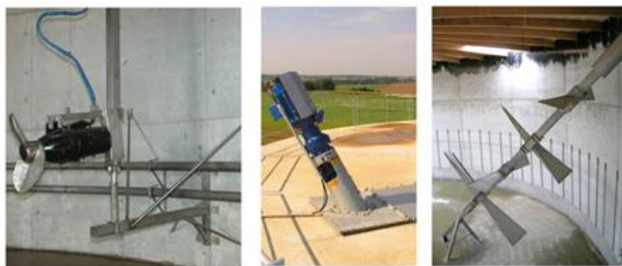
Abbildung 7.10: Tauchmotorrührwerk und Langachs-rührwerk, Bay. LfL, 2014
