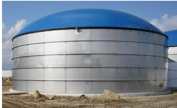
Abbildung 7.4: Edelstahlsegmentbehälter mit Doppelmembrandach, nicht isoliert, Fa Weltec
