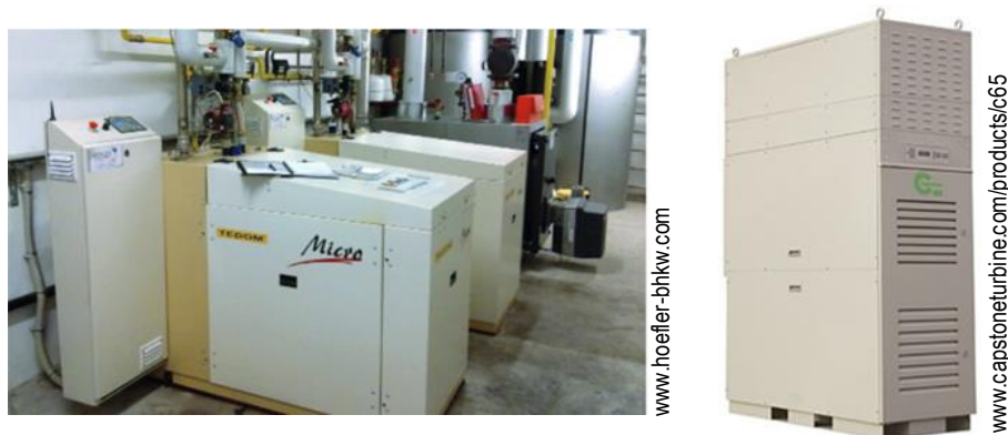
Abbildung 7.13: BHKW und Mikrogasturbine, Firmenangaben Höfner und Capestone
